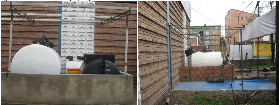
Figura 62. Fabricación de un tanque para prevención de derrames de aceite
