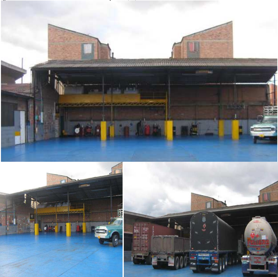
Figura 48. Vistas de las nuevas instalaciones de Lubripesados (LP)
