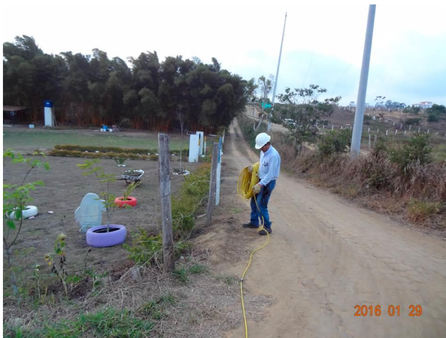
Figura 44 Instalación del multicable al electrodo para la Tomografía Eléctrica 2D T7.
