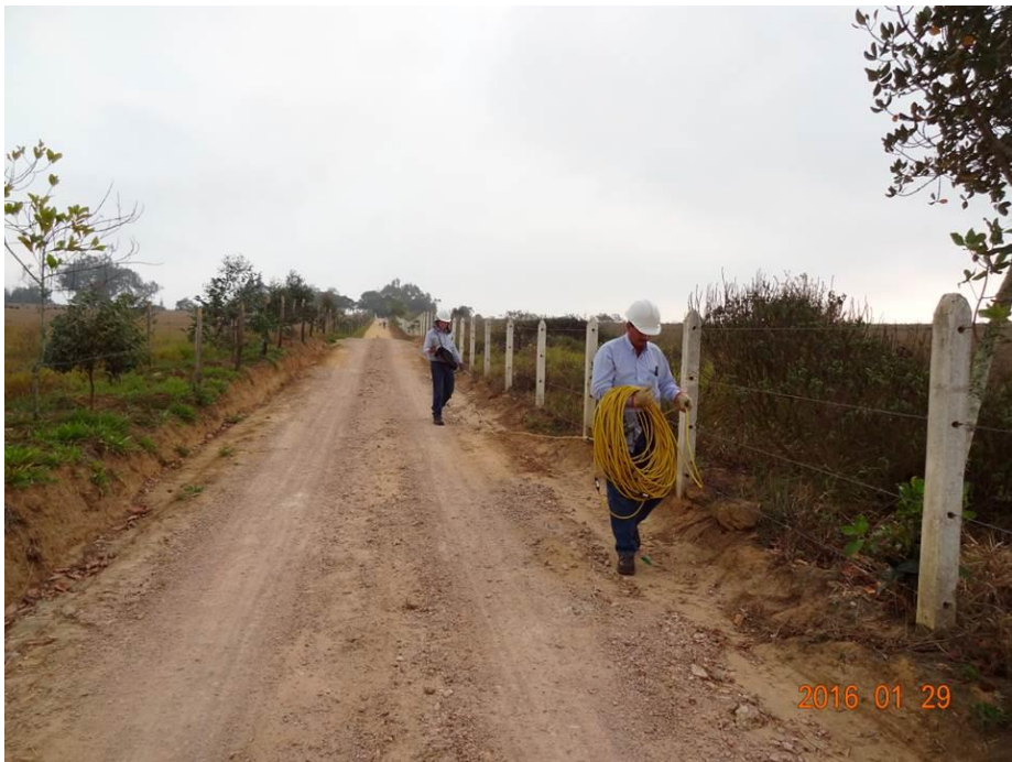
Figura 39. Instalación del multicable al electrodo para la Tomografía Eléctrica 2D T6.
