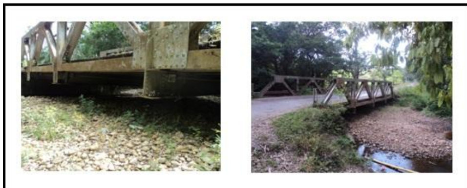
Figura 19. Puente Caño Bogas
