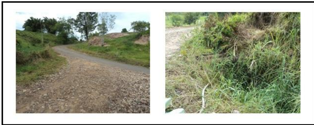
Figura 15. Entrada al Ramal que Conduce al PC49
