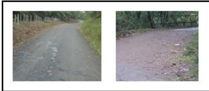
Figura 21. Recorrido del K2+300 al Puente La Llana
