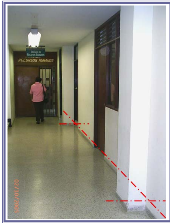
Figura 5. Ejes desplazados que no coinciden con los planos.
