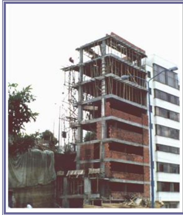
Figura 74. Edificio aporticado de concreto reforzado.
