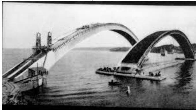
Figura 19. Cimbra reutilizable del Puente Plougastel, Río Élorn, Brest, Francia.
