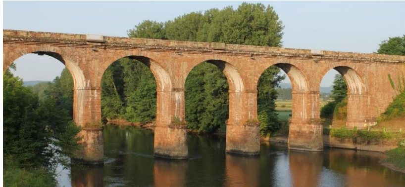
Figura 26. Puente ferroviario Saint Pantaleon (puente aperaltado), Larche, Francia.
