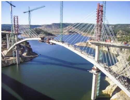
Figura 21. Viaducto Río Tajo, Embalse de Alcántara, España. Puente arco por voladizos sucesivos.
