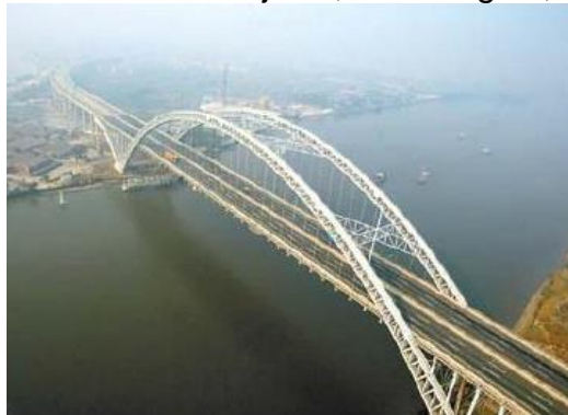
Figura 32. Puente Yajisha, Rio Zhugian, China.
