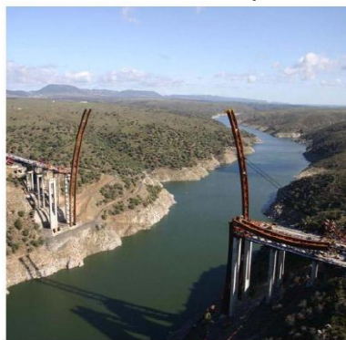
Figura 36. Viaducto Arcos de Alconétar, Embalse de Alcantara, Cáceres, Extremadura, España.
