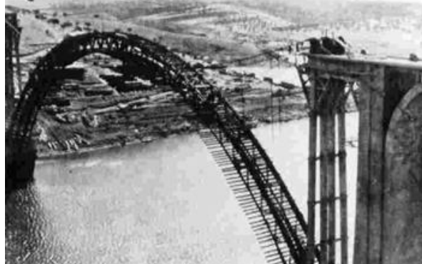
Figura 18. Autocimbra del Viaducto Martin-Gil, Zamora, España.
