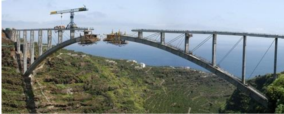
Figura 38. Puente de los Tilos, Islas Canarias, España.
