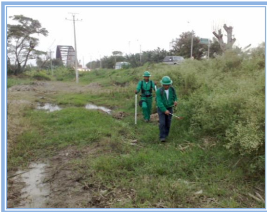
Figura 29. Técnica CIPS acompañada de equipo detector de tuberías
