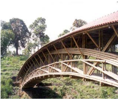
Foto 3 Puente peatonal en Guadua en la región cafetera
