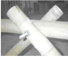
Foto 28 Unión en dos planos simétrica con anclaje en mortero y barra atravesada
