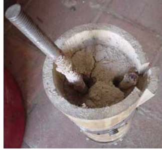
Foto 46 Falla elemento transmisor
