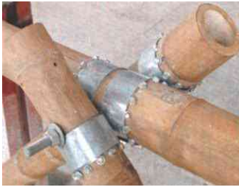
Foto 31 Unión en dos planos con un anclaje tipo abrazadera
