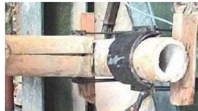
Foto 20 Falla por tensión a 90° para SVM
