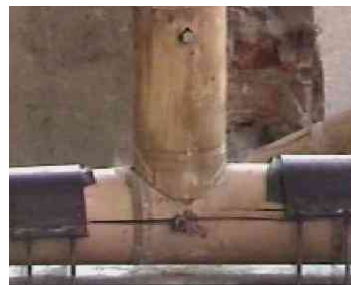
Foto 21 Falla por tensión a 90° para JS
