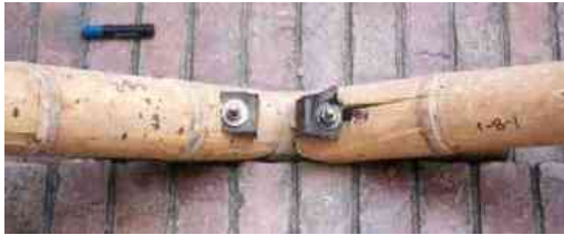
Foto 24 Falla por tensión a 45° y 60° para SVM.
