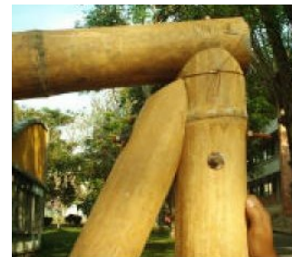
Foto 36 Unión esquinera utilizada por Jackson y Antonio en su tesis de páneces
