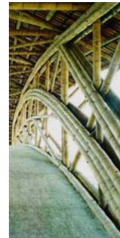
Figura 13 Unión diagonal en dos planos
