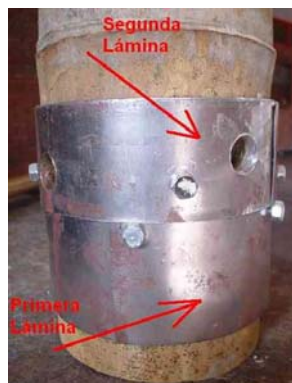
Foto 37 Detalle del refuerzo para el elemento horizontal
