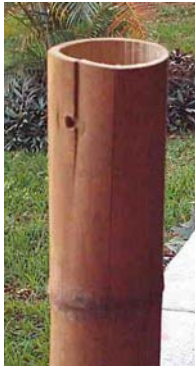
Foto 48 Cortante debido al aplastamiento
