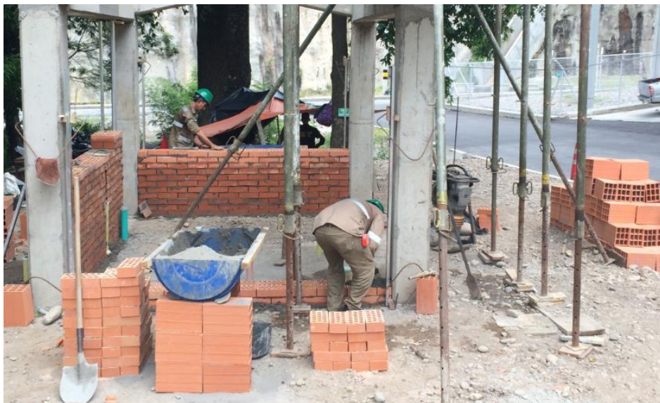
Figura 8. Proceso de mampostería - Casetas de vigilancia.
