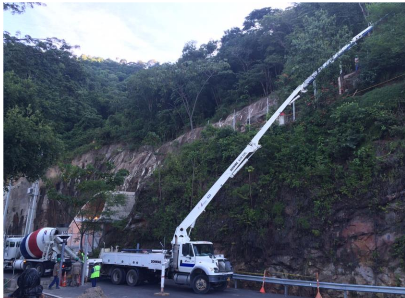
Figura 5. Bombeo de concreto para cimentación del cerramiento.
