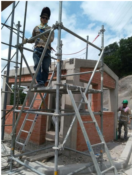
Figura 9. Instalación de la cubierta - Casetas de vigilancia.
