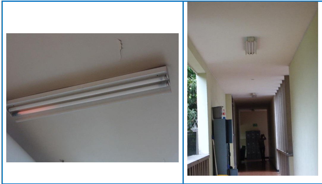
Figura 66. Pasillos y luminarias edificio Morfopatología.
