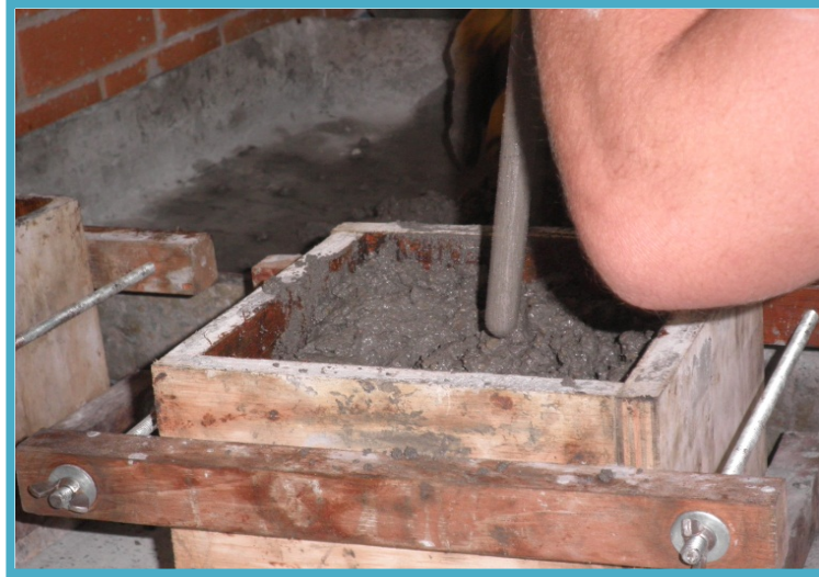
Figura 12. Apisonado de la mezcla con varilla compactadora.
