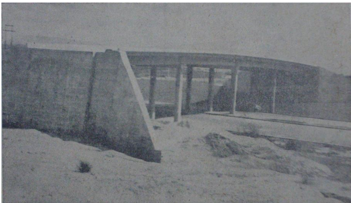
Figura 5. Puente de Provenza en abandono sin vías de acceso.
