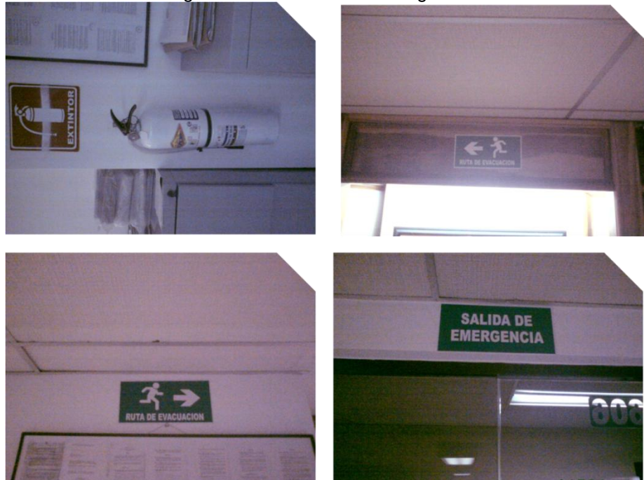
Figura 18. Señalización de Seguridad
