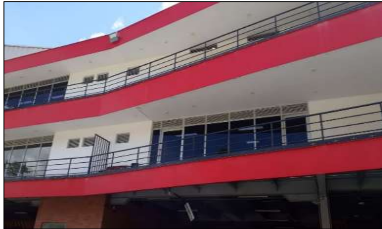
Figura 4. Toma de medidas de la fachada en Dispapeles.
