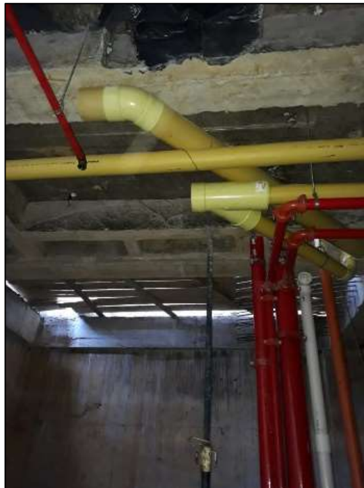
Figura 8. Visita y toma de datos en la obra PHARMASAN
