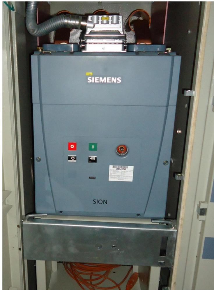
Los interruptores operan en las posiciones de servicio y prueba. Los interruptores deben extraerse a la posición de prueba con la puerta cerrada. El mecanismo de accionamiento para la inserción y la extracción del interruptor, en el caso del tipo extraíbles, deben disponer de algún dispositivo, que no obligue al operador a efectuar esfuerzos mayores para ejecutar la operación deseada. Este mecanismo deberá además dar una señal positiva de fin de carrera para evitar daños al
