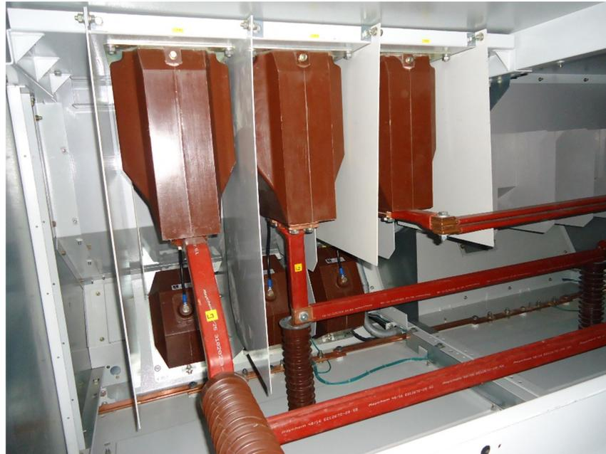
Se clasificaron en dos grupos estos transformadores: Transformadores de Tensión (PT's) y Transformadores de Intensidad (CT's)
