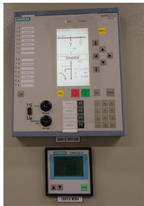
Instrumentos de medida digital (Voltaje, corriente, potencias) que permiten indicación local en display y además integración de las mediciones al sistema digital para automatización de subestaciones.
