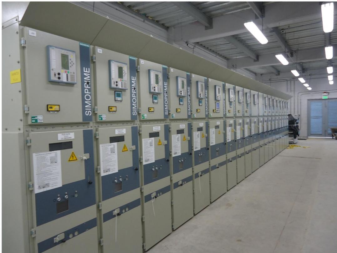
El endosamiento de dos cubículos de celdas ya sea por pared compartida o doble pared metálica, posee propiedades tales que aseguren la no propagación de un cubículo de celda a otro, daños originados por fallas producidas por arcos internos.
