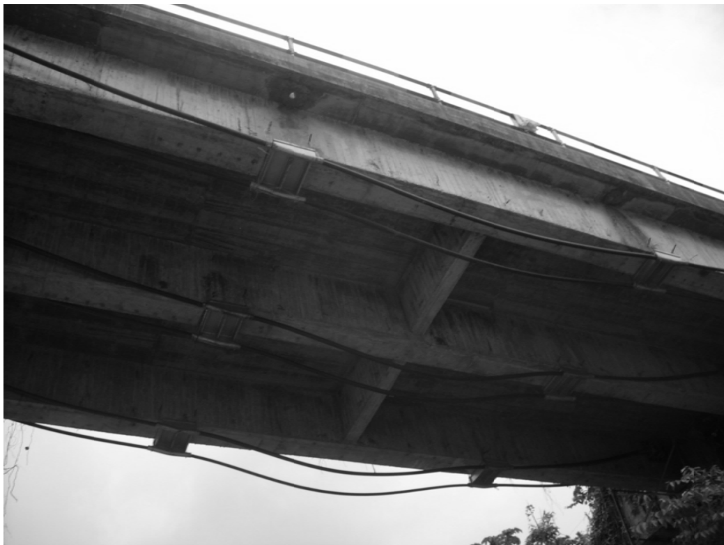
Figura 27. Presforzado Exterior 16
