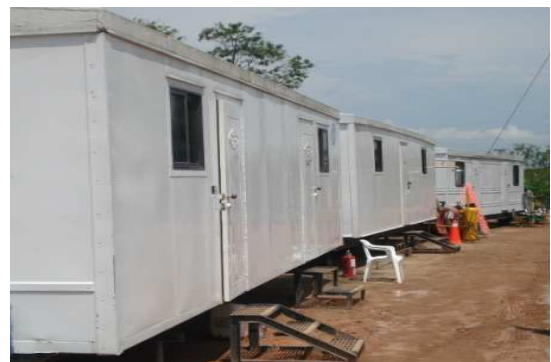
Fotografía 16 Adecuación área del campamento
