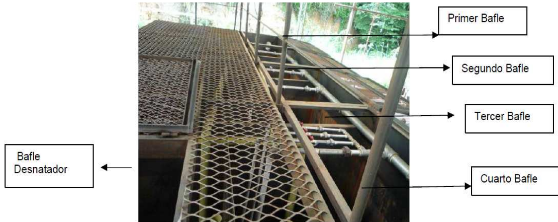
Fotografía 53 Vista Superior Planta de Tratamiento de Agua Residual
