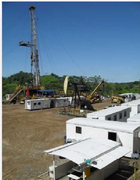
Fotografía 1 Pozo durante la operación de perforación
