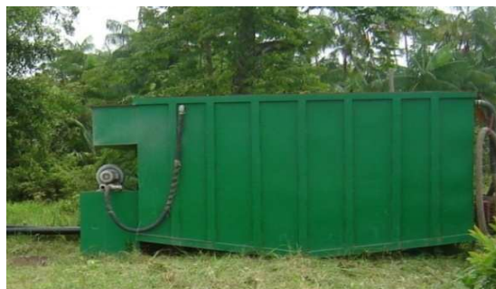
Fotografía 5 Vista Lateral PTAR
