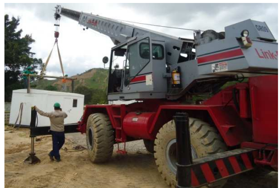
Fotografía 14 Descargue e instalación campamento según layout.
