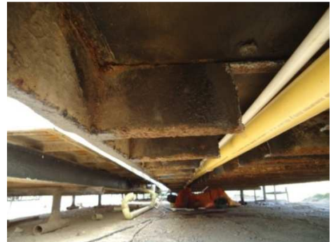
Fotografía 20 Conexión de tuberías
