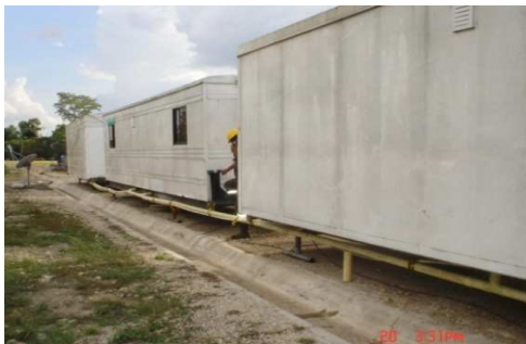
Fotografía 21 Conducción aguas negras
