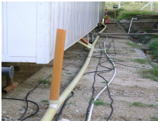
Fotografía 38 Cierre y purga del sistema
