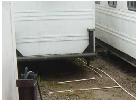
Fotografía 19 Tendido tubería agua potable
