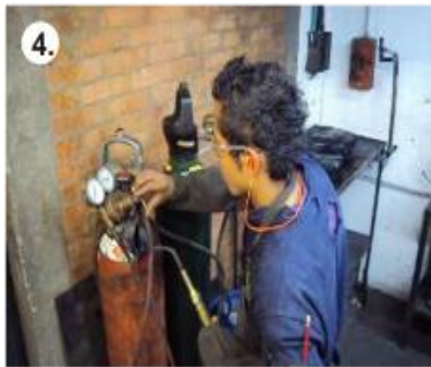
4. Accione (profundice) el tornillo de regulación de acetileno, verifique y ajuste la presión de trabajo requerida
