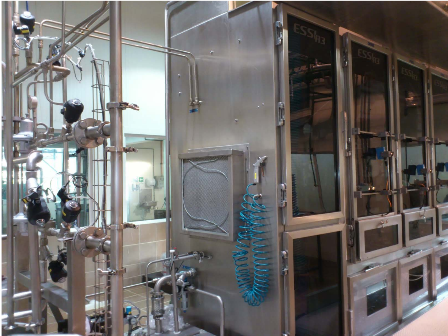
Anexo O. Máquina Empacadora Aséptica ESSI A3 instalada en Lechesan S.A.
