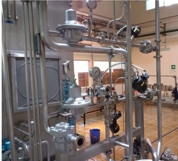
Figura 34. Juego de válvulas para el CIP de la ESSI A3.
