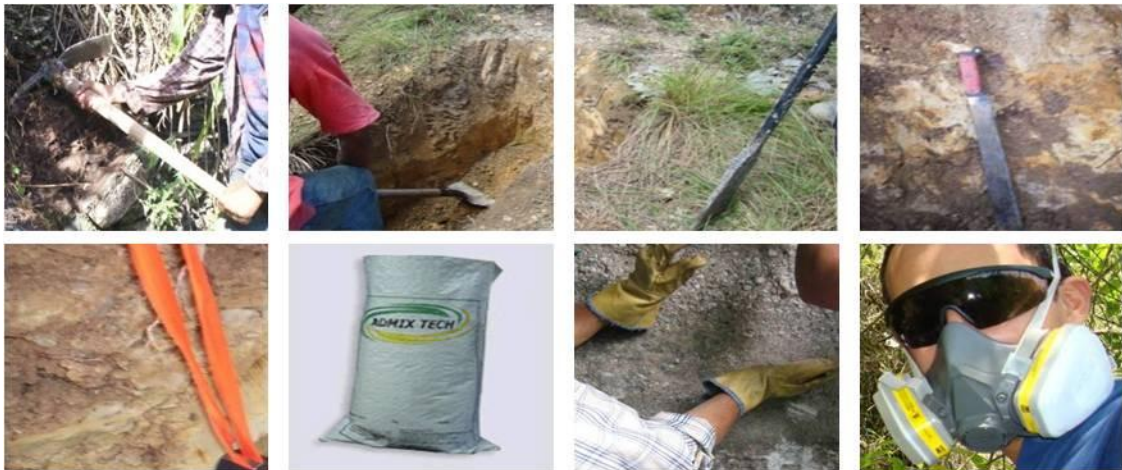
Figura 2. Implementos necesarios para la excavación de trincheras.
