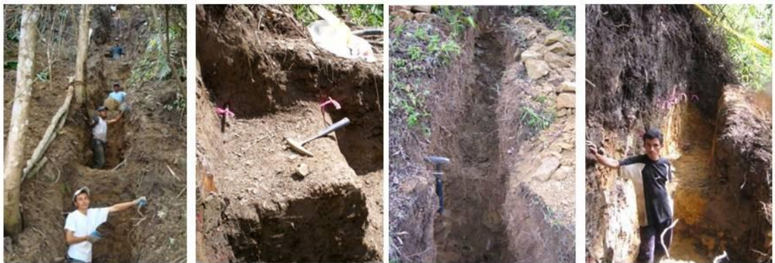
Figura 3. Ejemplos de trincheras
