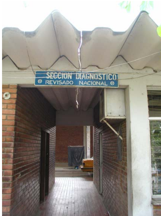
Fotografía 7. Pasillo intermedio y techo actual del Centro en el área administrativa.
