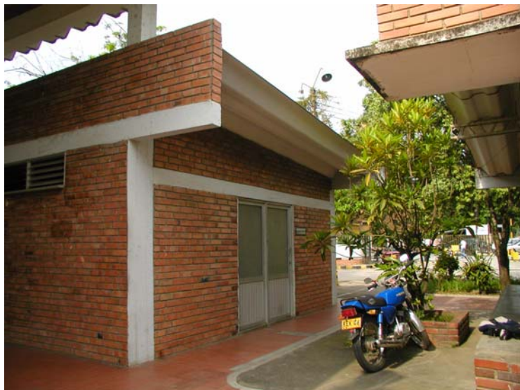
Fotografía 11. Fachada actual del área administrativa.
