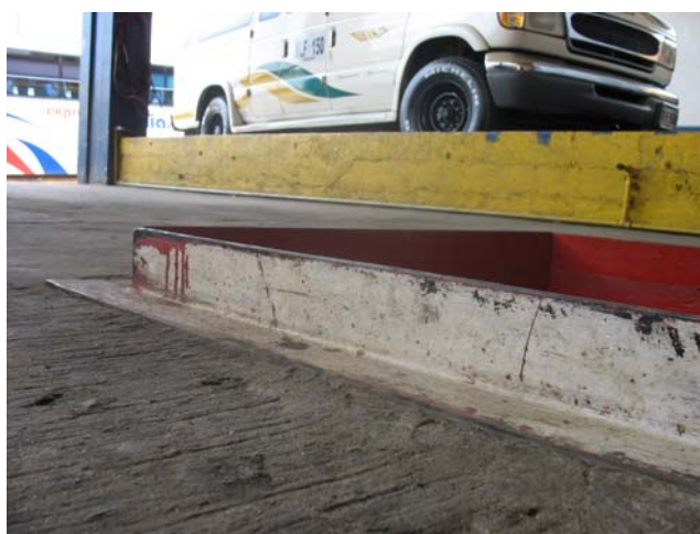
Fotografía 9. Detalle del ángulo en el borde del cárcamo.
