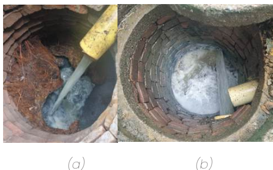
Fotografía 9. Cámaras de inspección de nuestra comunidad: CP9 (a) y CPI0(b)
