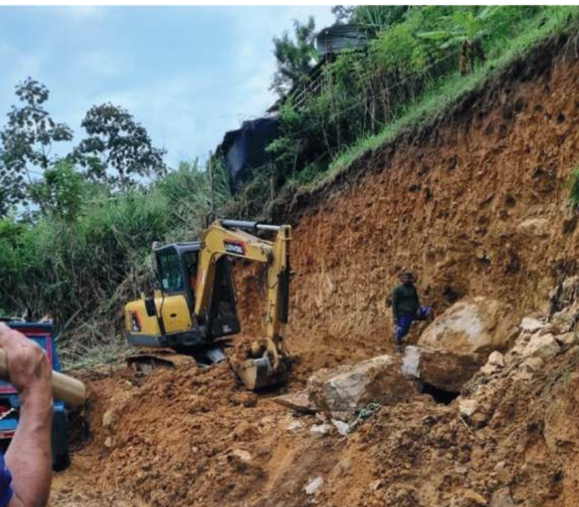
Fotografía 6. Reparación de la vía que comunica Miradores de la UIS con El Porvenir.
