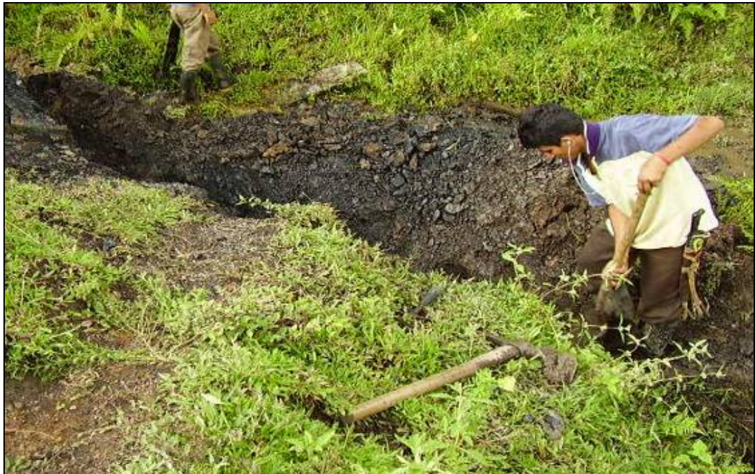
Figura 50. Excavación de trinchera, en la bloque sur, con el fin de establecer los datos del afloramiento
