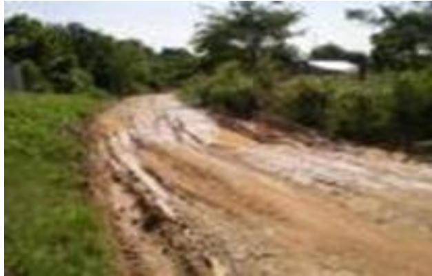
Figura 3. Vía de acceso deteriorada por fuertes lluvias
