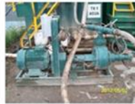
Bombas y mangueras para desplazar lodo y polímero a la centrifuga decantadora.
