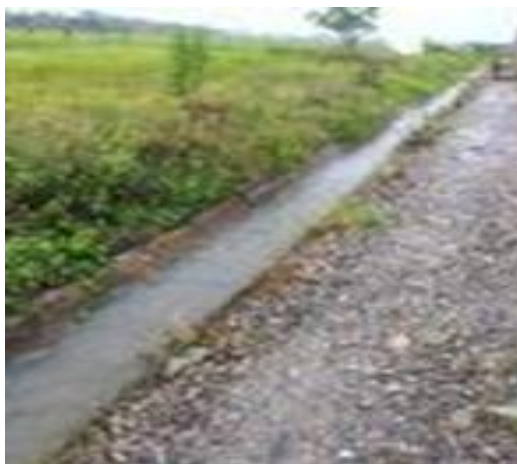
Figura 12. Canal de agua lluvia
