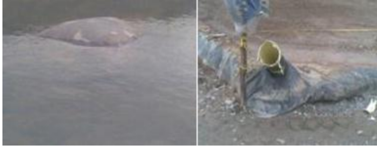
Figura 15. Geomembrana levantada y piezometro
