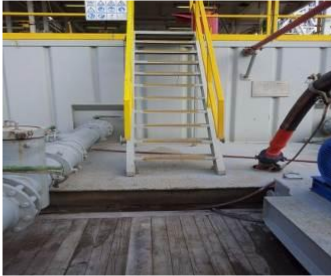
Figura 25. Acceso a tanques de succión
