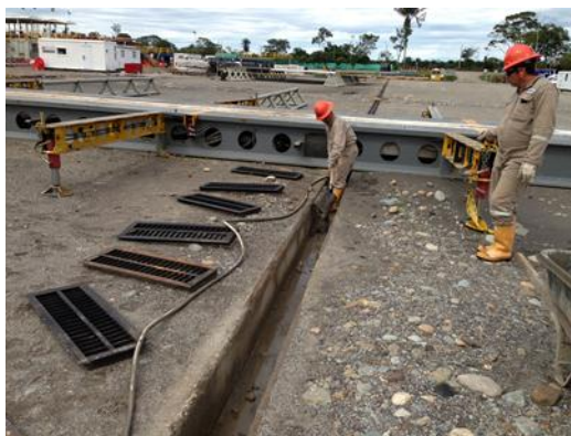
Figura 11. Canaleta y rejillas
