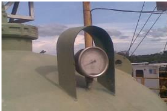
Figura 46. Manómetro desgasificador
