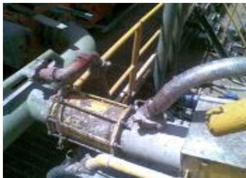
Figura 18. Conexión de bomba a Flow Line
