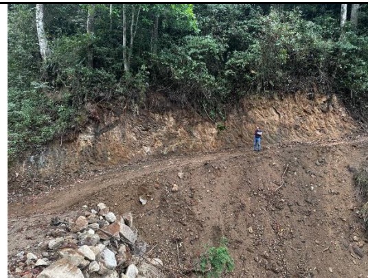
Fotografía No.5 Parte alta del talud.
