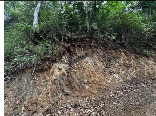
Fotografía No. 3 Cortes al talud.
