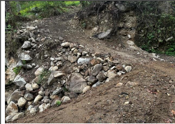
Fotografía No. 2 Parte alta del talud.
