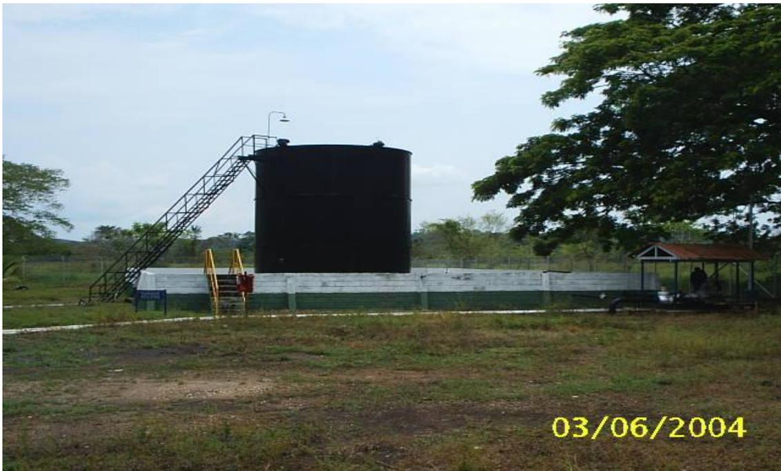
❖ **Estaciones Auxiliares Cantimplora y Carare:** Corresponden a las estaciones intermedias entre Zambito y la estación terminal El Sauce y cumplen exactamente la misma función: imprimir energía al fluido para impulsarlo nuevamente a la línea de transporte hacia la otra estación intermedia o hacia la estación terminal.
