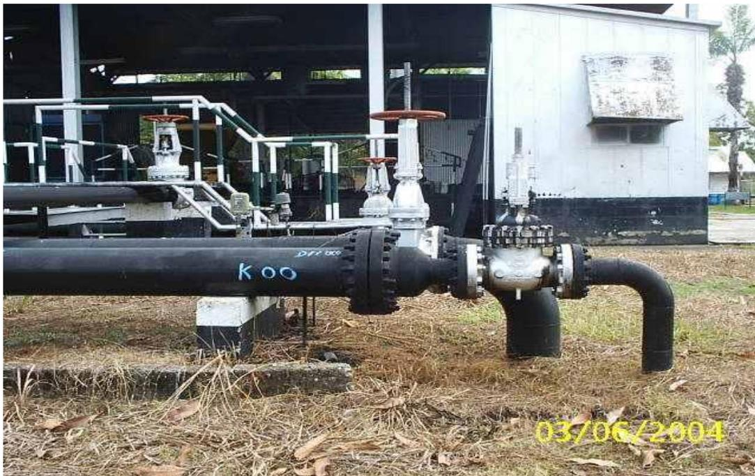
Figura 9. Sistema de By-Pass de la estación Velásquez – 26
