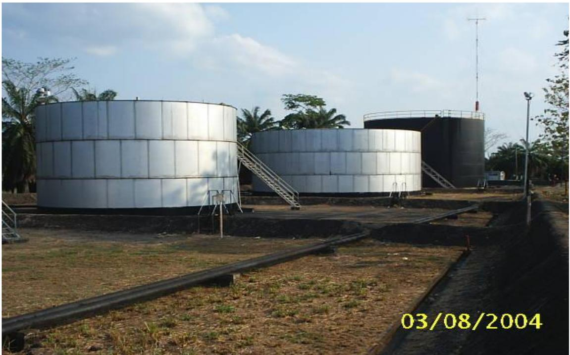
Figura 4. Tanque de recibo de crudo diluyente.
