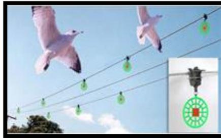
Figura 12. Desviadores de vuelo *firefly diverters*
