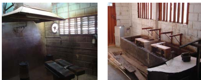
Imagen 68. Iluminación y ventilación de pintura y carpintería
