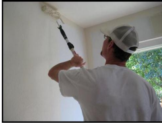
Figura 9. Trabajador aplicando pintura sobre muros.
