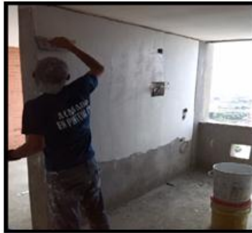
Figura 7. Aplicación de estuco sobre muros.
