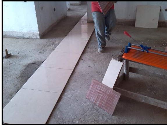
Figura 11. Ubicación de referencias para iniciar instalación de pisos.
