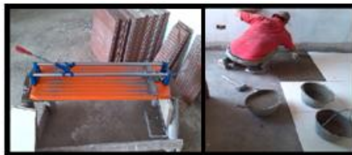
Figura 12. Instalación de pisos.
