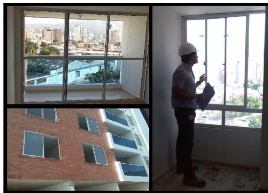
Figura 15. Carpintería metálica presente en el proyecto.
