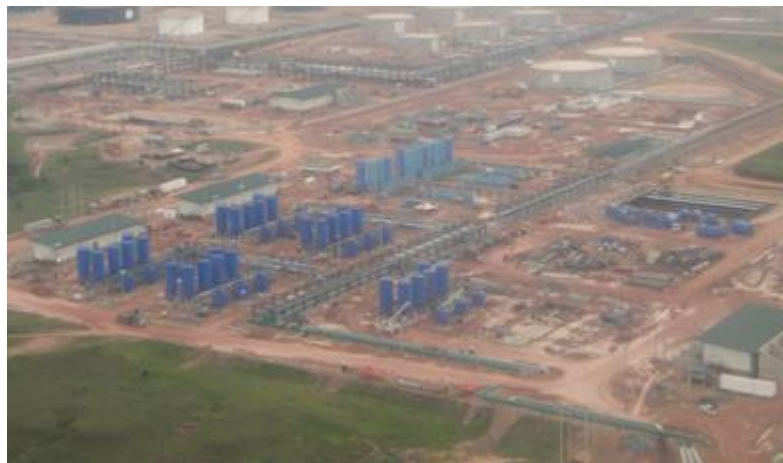
Figura 13. Imagen área ocupada sistemas de tratamiento de agua CPF2 de Rubiales. Capacidad 1950KBWPD.
