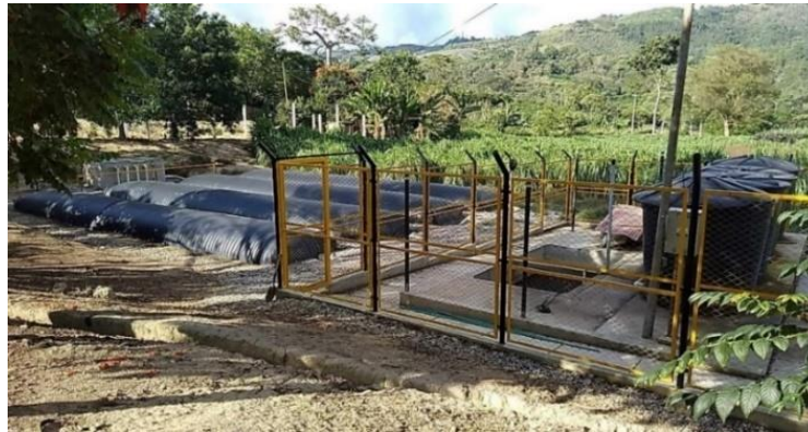
Figura 4. Instalación de biodigestores
