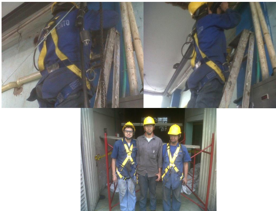
Imagen 11: Trabajo en alturas
