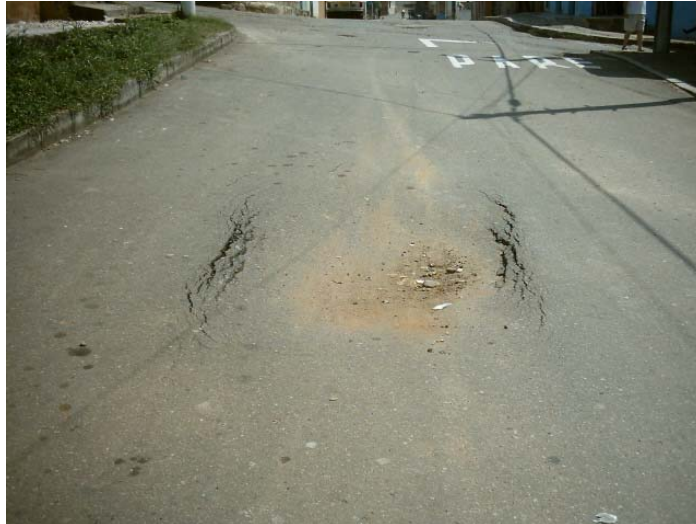
Figura 16. Hundimiento
