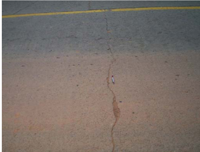
Figura 26. Grietas Transversales.
