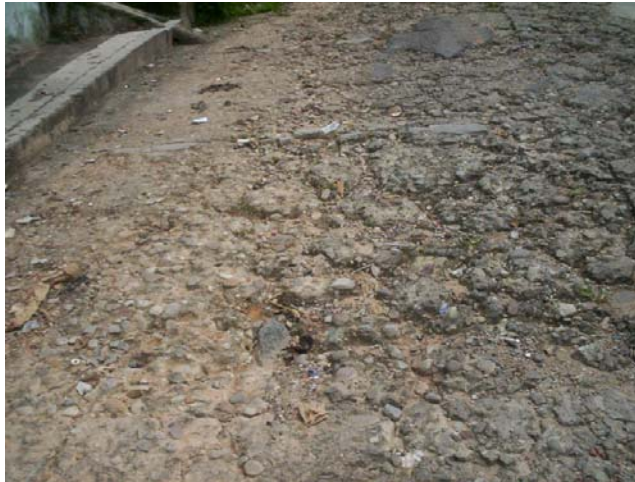
Figura 27. Desintegración.
