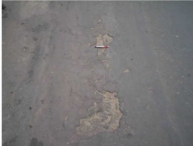
Figura 20. Descascaramiento.
