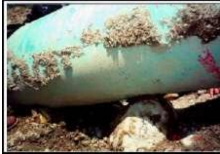
Figura 30. Abolladura ocasionada por deslizamiento de tierras.
