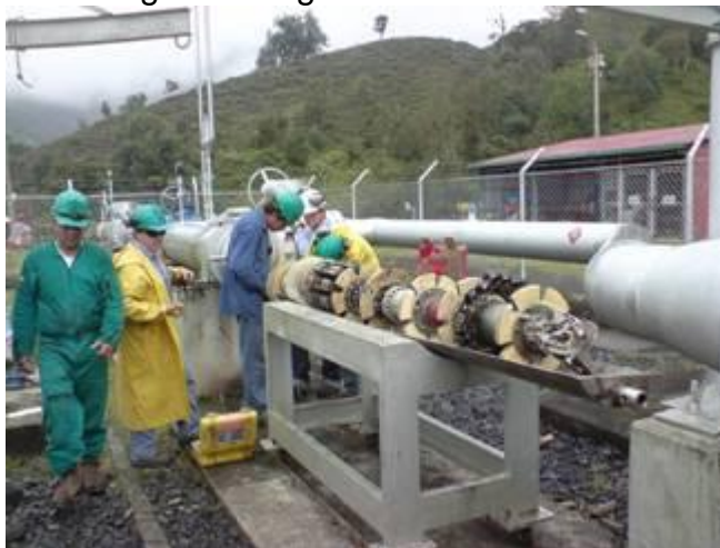
Figura 23. Inspección Inteligente del gasoducto
