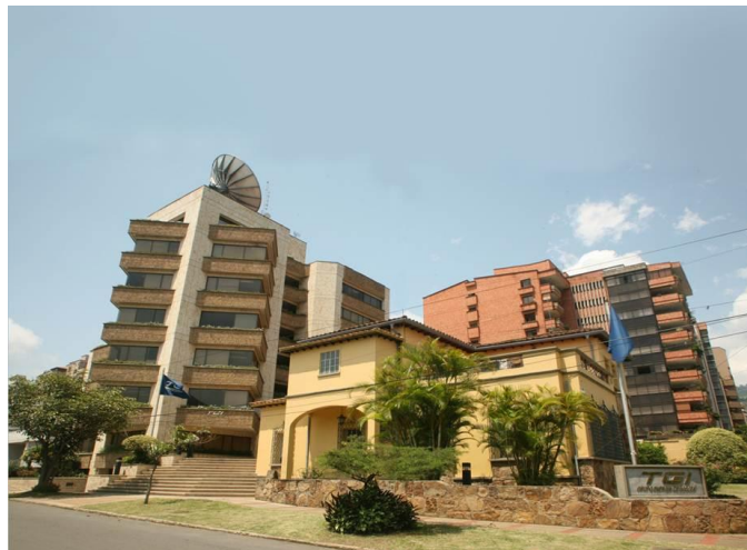
Figura 16. Instalaciones de TGI S.A. E.S.P.
