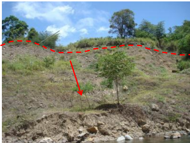
Figura 19. Cresta y dirección del deslizamiento.
