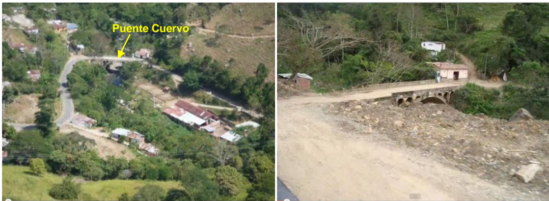
Figura 5. Vía de acceso a Gramalote antes y después del deslizamiento.
