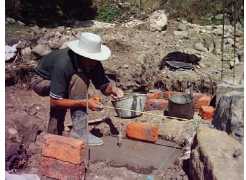
CONSTRUCCION DE LAS CAJAS
