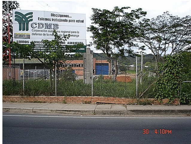
SECTOR INDUSTRIAL HARINERA DE SANTANDER – PUENTE PALENQUE. VISTA DEL SECTOR ORIENTAL DEL ANILLO VIAL EN EL PUENTE PALENQUE. EN EL PUNTO SEÑALADO SE UBICARÁ EN POZO DONDE SE CONECTARÁ EL COLECTOR AL CRUZAR EL ANILLO VIAL
