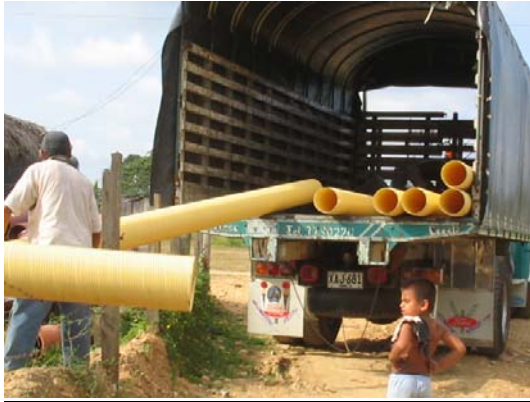
SUMINISTRO DE TUBERIA P.V.C
