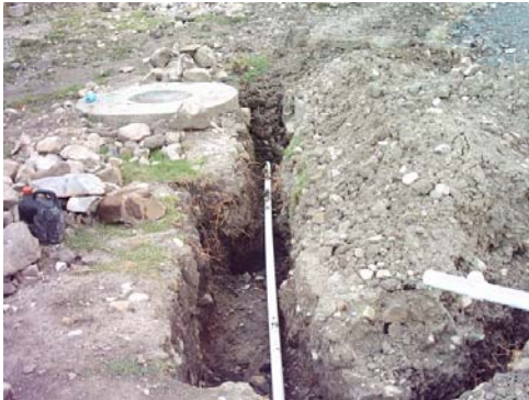
INSTALACION DE TUBERIA
