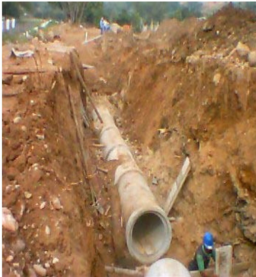
INSTALACIÓN DE TUBERÍA
