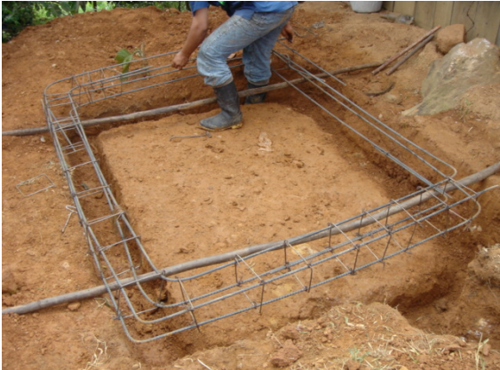
Proceso constructivo de las unidades sanitarias
