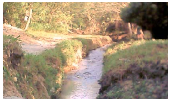
Vista desde la parte superior de la grada construida para disipar la energía de la caída de las aguas.
