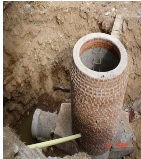
POZO DE INSPECCIÓN
