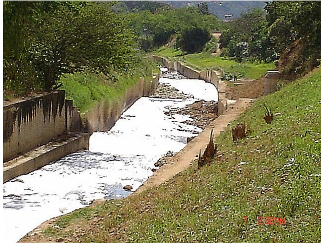
SECTOR CENTRO POLIFUNCIONAL - MERCAGAN OBRAS DE ESTABILIZACIÓN DE TALUDES Y FMPRADIZACIÓN
