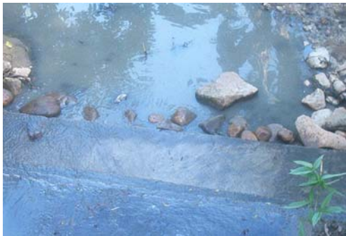
Vista desde la parte superior de la grada construida para disipar la energía de la caída de las aguas.
