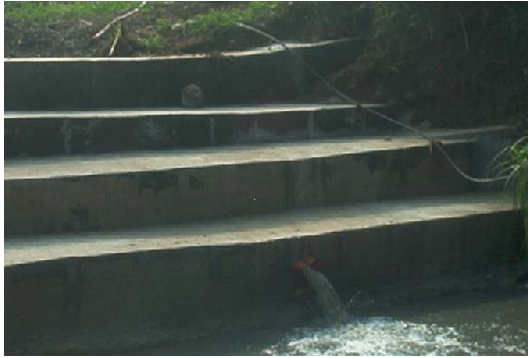
Estructura de control de Cauce. Hecha de gaviones recubierto en concreto y por donde pasan dos tubos de 4" y dos tubos de 3" que transportan las aguas del canal.
