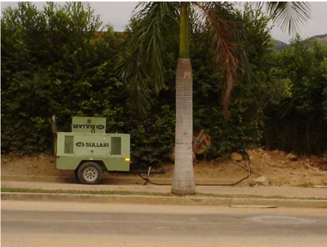
SECTOR METAL MARKET – ITALCOL COMPRESOR USADO POR EL CONTRATISTA PARA DEMOLICIÓN DE ESTRUCTURAS EN EL PUENTE DE ACCESO AL CARRASCO
