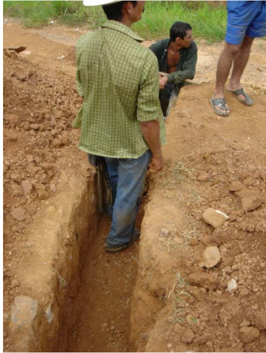
Abertura de la chamba donde se instalará la tubería.
