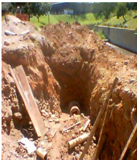
PREPARACIÓN DEL TERRENO CONSTRUCCIÓN DE POZO
