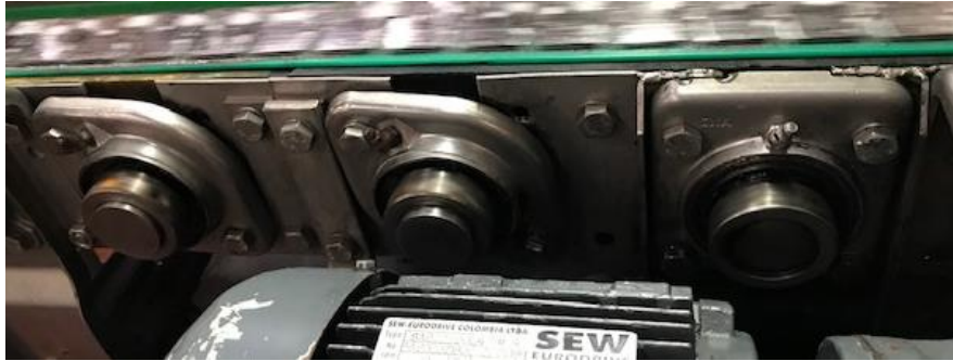
Figura 2. Instalación de soportes de pared
