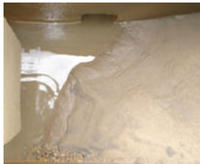
Fotografía 52. Material granular sedimentado. Municipio de La Gloria.
