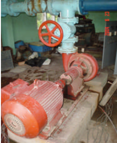
Fotografía 60. Bomba Siemens de 30Hp. Municipio de La Gloria.
