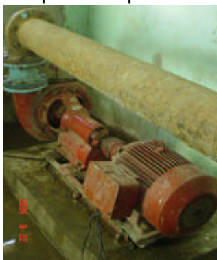
Fotografía 47. Bomba Siemens de 30Hp. Municipio de La Gloria.
