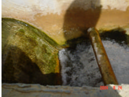
Fotografía 74. “Flauta” dosificadora. Municipio de Pailitas.
