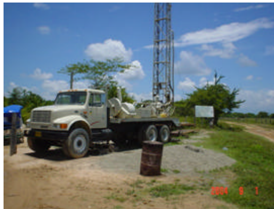
Fotografía 25. Perforación de un nuevo pozo en Chiriguana.
