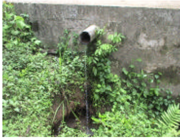
Fotografía 70. Desarenador del sistema Qda. Verde. Obsérvese el orificio de rebose.
