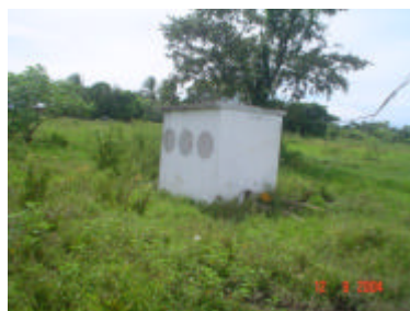
Fotografía 15. Pozo vía urbanización Padilla. Municipio de Chimichagua.
