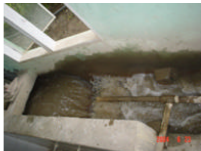
Fotografía 50. Coagulación y mezcla rápida. Municipio de La Gloria.
