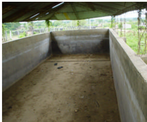
Fotografía 12. Tanque semienterrado.
