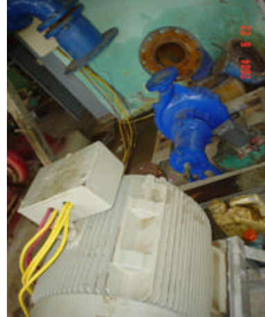
Fotografía 61. Bomba Siemens de 60Hp. Municipio de La Gloria.
