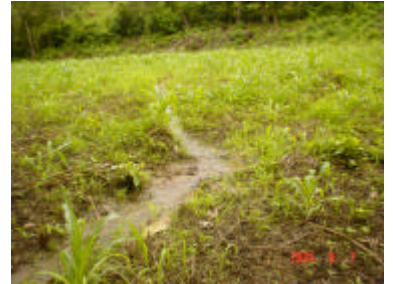
Fotografía 71. Aducción del sistema Qda. Verde. Obsérvese el riachuelo producido por una fuga.
