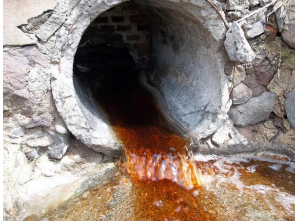
Figura 3. Aguas residuales industriales
