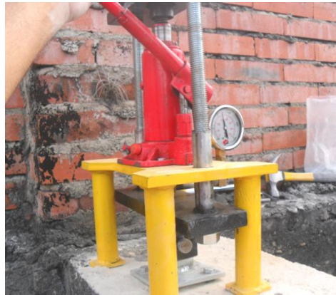
Figura 74. Verificador aplicando carga al conector de anclaje.
