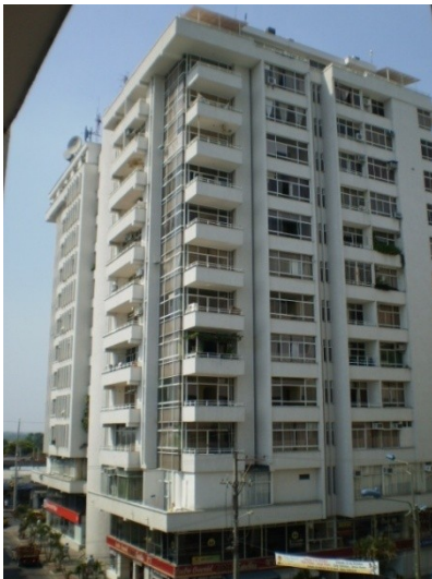
Fotografía 2. Edificio Superestrellas Barrancabermeja.
