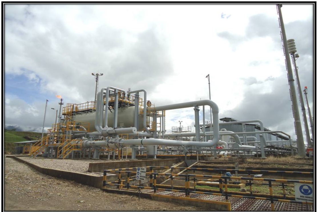
Fig. 5 Separador de producción V-1001
