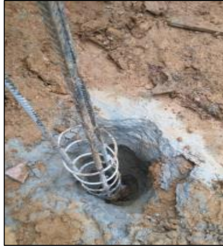
Figura 16. Micropilote inyectado
