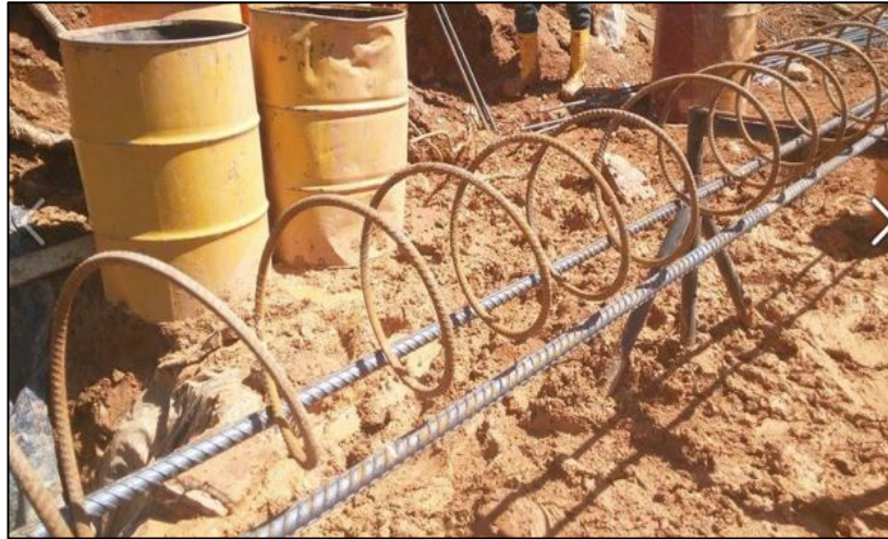
Figura 15. Perforación de micropilotes
