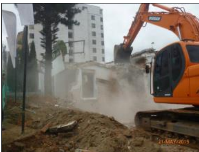
Figura 9. Demolición viviendas existentes
