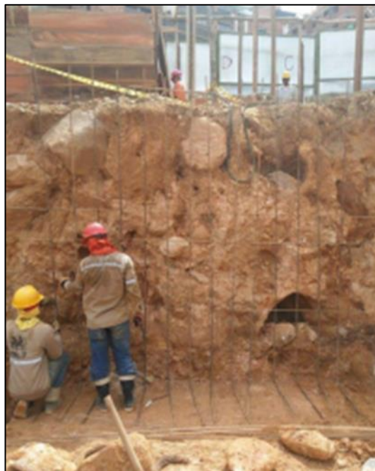
Figura 19. Armado del muro de contención
