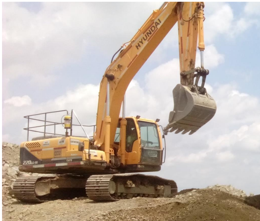
Figura 75. Retroexcavadora Hyundai 220LC-9S
