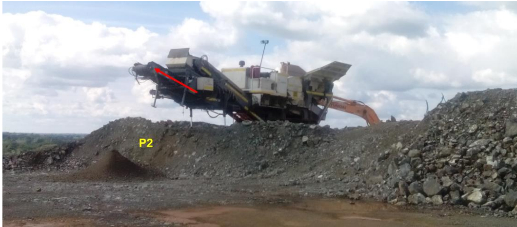
Figura 84. Salida de materiales de la trituradora. Se observa salida de Producto 2
