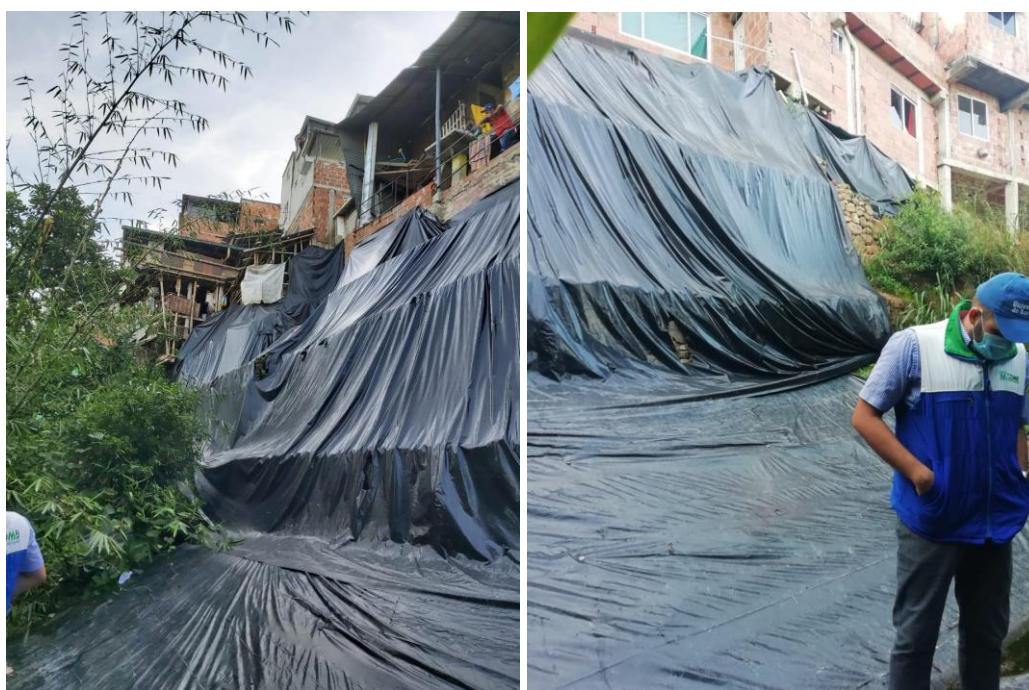
Ilustración 4: Impermeabilización con plástico de polipropileno color negro
