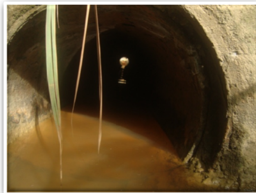
Foto 12: Inspección tubería alcantarilla
