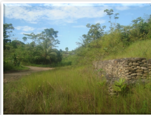
Foto 10: Inspección muro de contención en gavión
