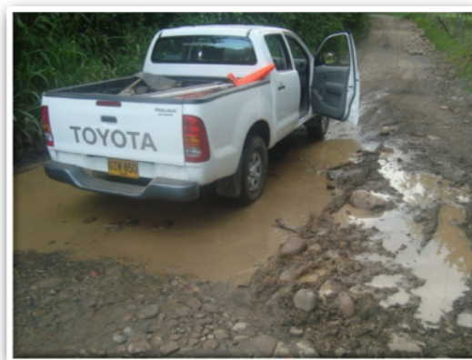
Foto 13: Sitio crítico en la vía
