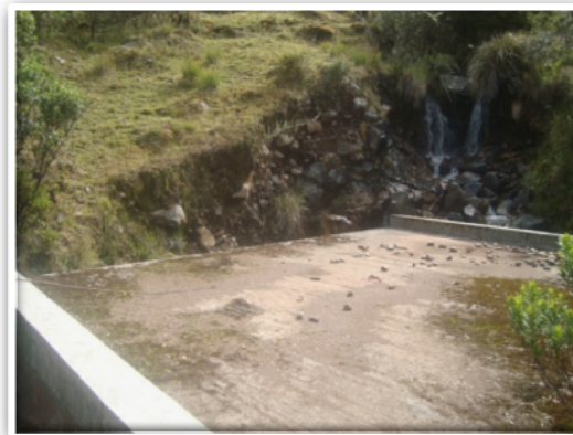
Foto 35: Vía sin terminar su construcción
