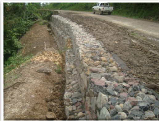
Foto 26: Muros de contención
