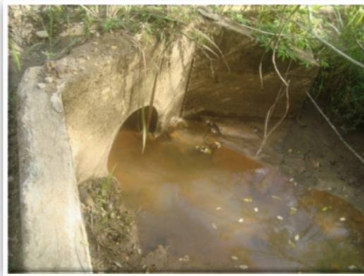
Foto 9: Inspección estructura de salida de alcantarilla
