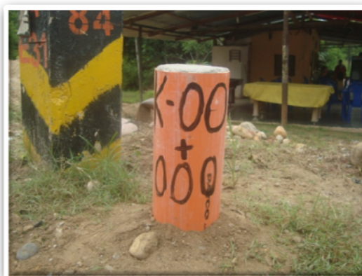
Foto 5: Mojon inicio de la via
