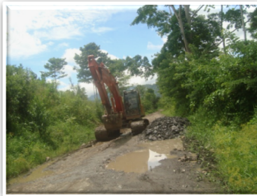
Foto 29: Inspección de superficie de rodadura
