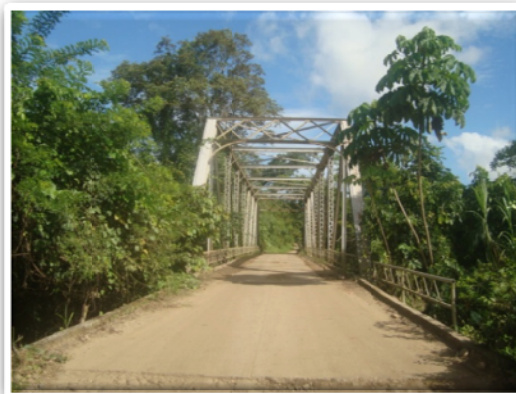
Foto 8: Puente de estructura metálica
