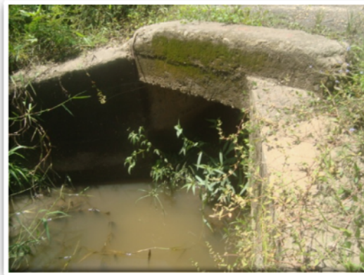
Foto 28: Detalle de alcantarillas
