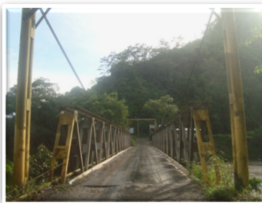
Foto 27: Inspección de puentes
