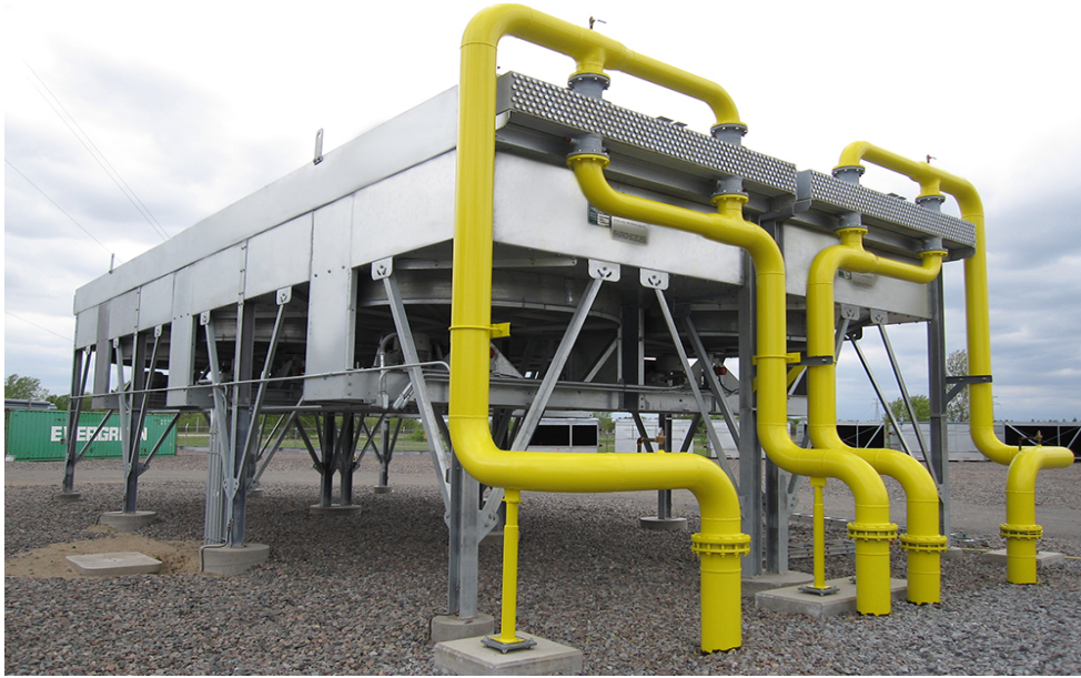
Figura 130. Los dos tipos básicos de enfriadores aéreos. Adaptada de Aiche. Disponible en: https://www.aiche.org/resources/publications/cep/2017/january/improve-air-cooled-heat-exchanger-performance y Youtube . Disponible en: https://www.youtube.com/watch?v=OyKAKhye87Q
