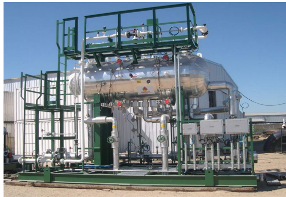
Figura 21. Separador horizontal. Adaptada de All Biz. Disponible en: https://all.biz/ar-es/separadores-de-ensayo-g54487
