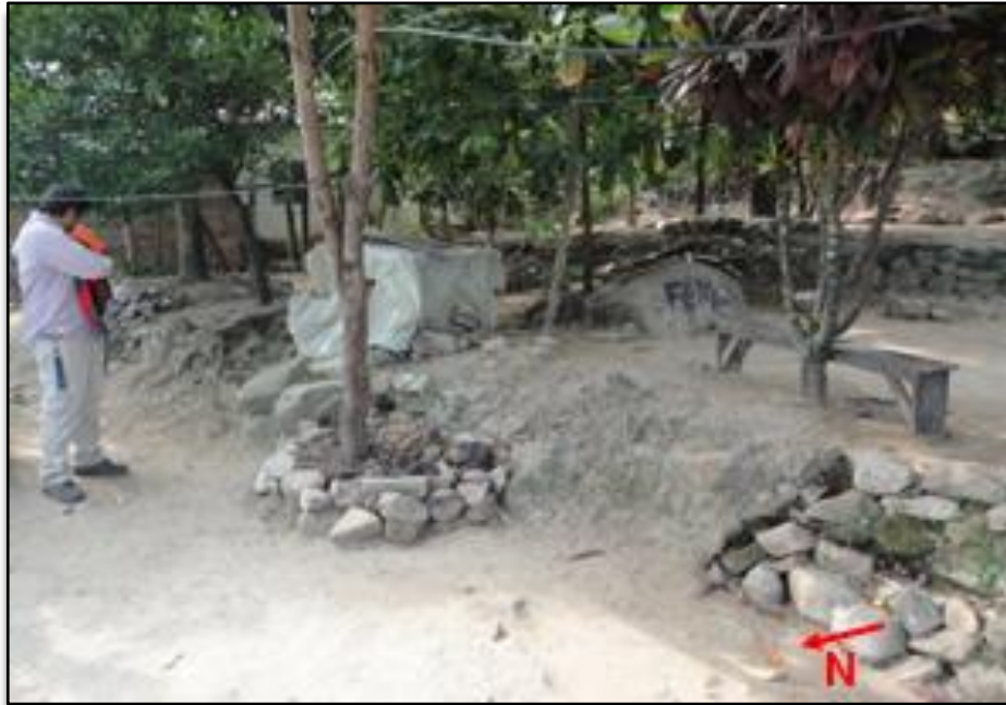
Figura 90. Corte en la ladera media del miembro Gravoso, con fines de construcción de viviendas.
