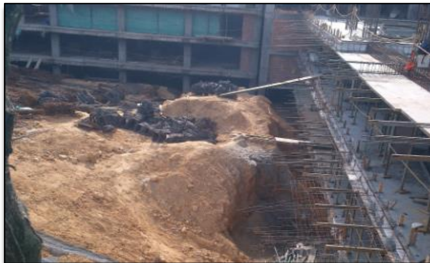
Figura 76. Suelos Limos Rojos, observados en la construcción del conjunto residencial cercano al sector conocido como “La Virgen”
