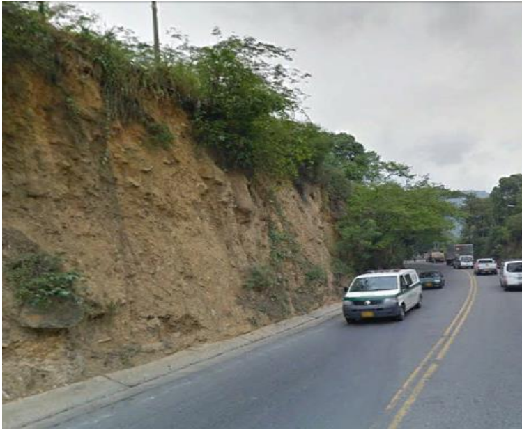
Figura 26. Miembro “Finos” sobre la vía al Norte
