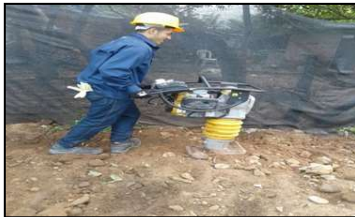
Figura 13. Maquina pisón compactador con su respectivo elemento de seguridad
