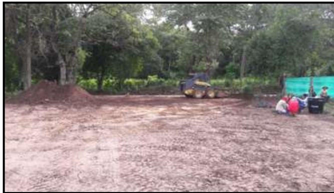
Figura 11. Acumulación material de excavación y posteriormente cubierto con material plástico.
