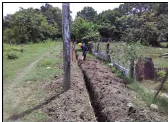
Figura 17. Orden y manejo de material de excavación al costado del tramo de la obra para mejorar la selección de material de relleno y desechos.
