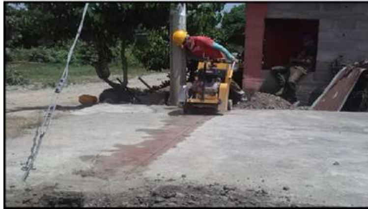
Figura 12. Maquina sellador para juntas de dilatación con sus respectivos elementos de seguridad.
