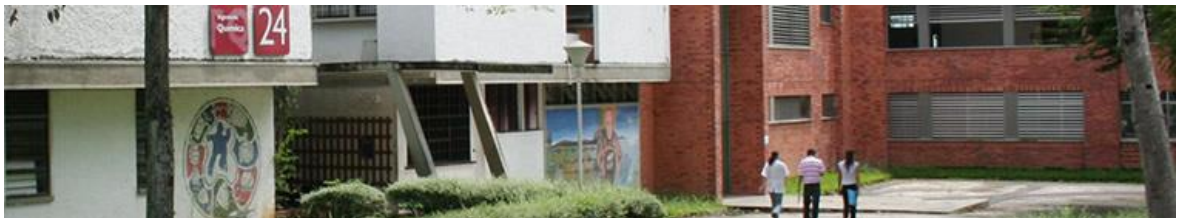
Figura 3. Vista frontal edificio Ingeniería Química.
