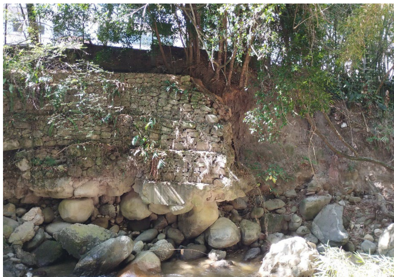
Foto 2 Socavación del Río Frío en la base de los muros de contención– Fuente: Estudio CDMB
